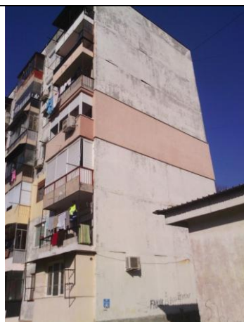
Югоизточна фасада, бл.16
