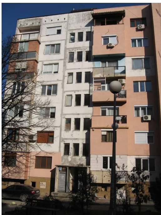
фиг.1.1 Западна фасада, бл.7, вх."А" вх."Б"
