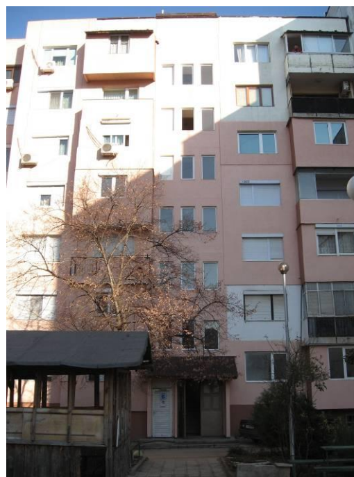
фиг.1.2 Западна фасада, бл.7,
