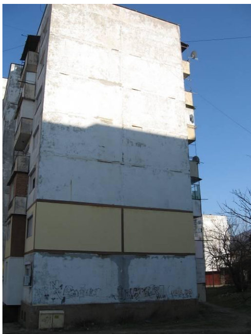
фиг.1.5 Западна фасада, бл.8
