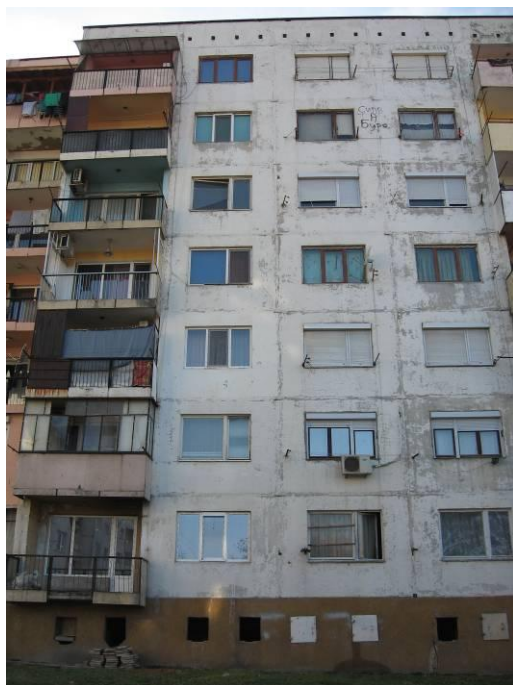
фиг.1.10 Източна фасада, бл.7,
