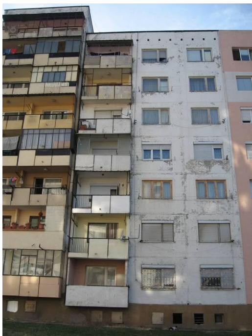
фиг.1.9 Източна фасада, бл.7, вх."Б" вх."А"
