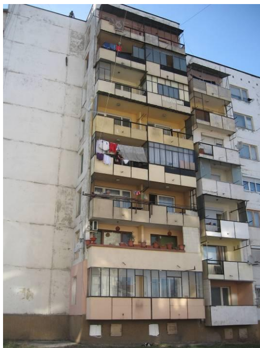
фиг.1.8 Източна фасада, бл.10
