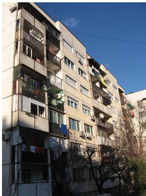
фиг.1.10 Южна фасада, бл.5, вх."Б"
