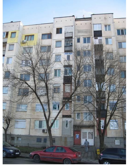
фиг.1.4 Северна фасада, бл.5, вх."Б"
