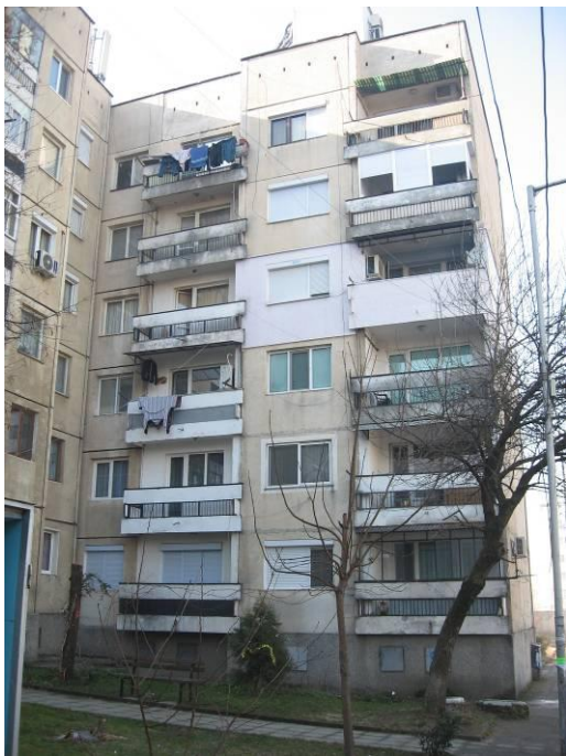
фиг.1.5 Източна фасада, бл.9
