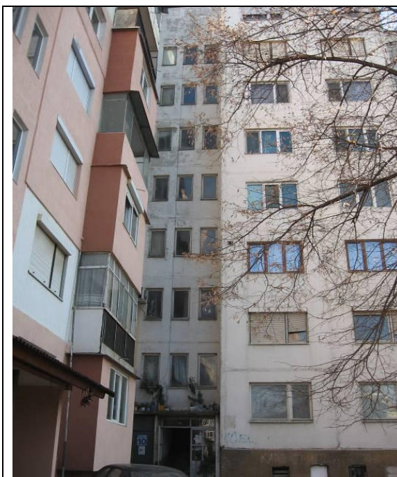
Северна фасада, бл.10
