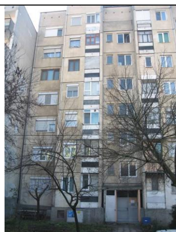
Северна фасада, бл. 8
