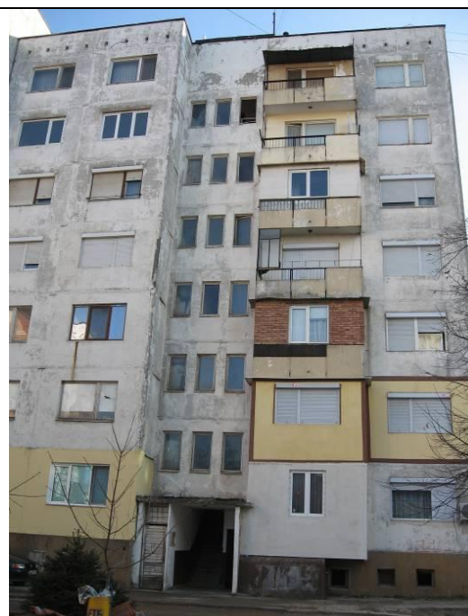
Северна фасада, бл.8
