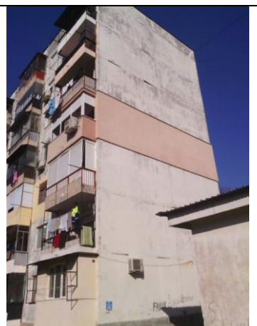
Югоизточна фасада, бл.16
