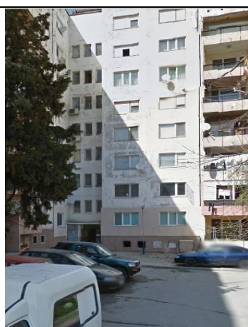
Югоизточна фасада, бл.15
