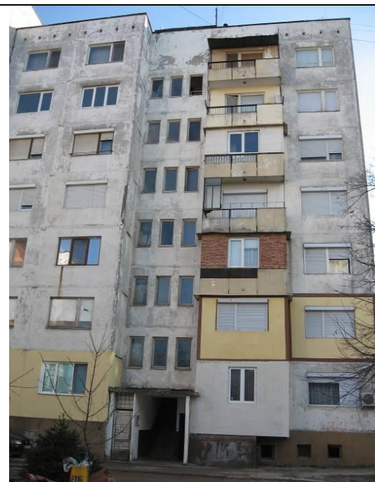
Северна фасада, бл.8
