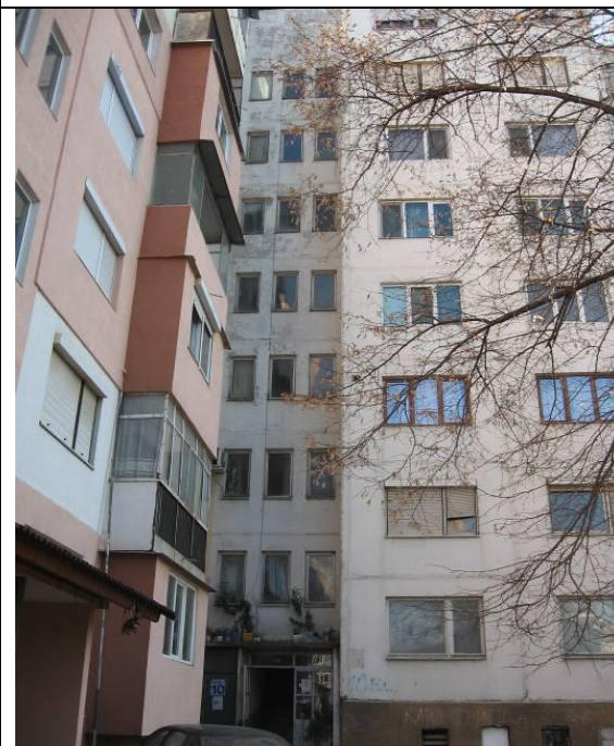
Северна фасада, бл.10
