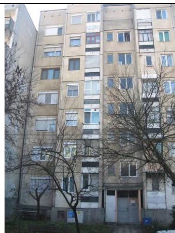
Северна фасада, бл.8
