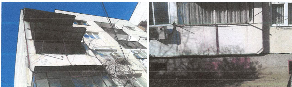
3 .5. Течове и просмукване на влага в стоманобетонен елемент
