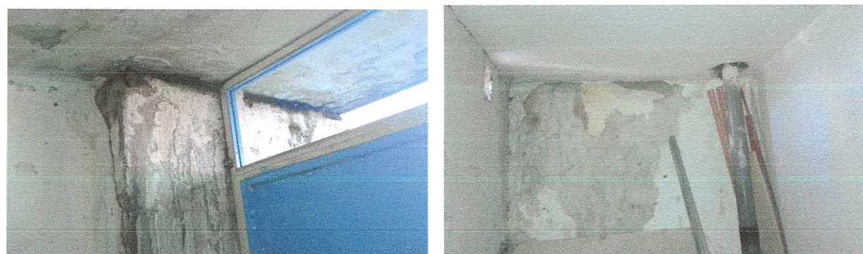
3 .5. Течове и просмукване на влага в стоманобетонен елемент
