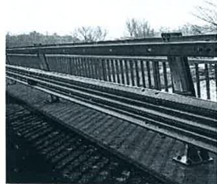
Стоманените предпазни огради след набиване биват изпитвани чрез краш тестове (изпитване на удар), съгласно БДС EN 1317. Те гарантират оставане на превозното средство в габарита на пътя, по-голяма безопасност на пътниците и по-малко поражения върху превозното средство при евентуален удар в стоманената предпазна ограда.
