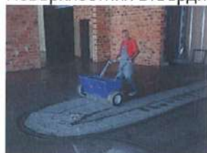
Шлайфане на бетона - Етап 1
