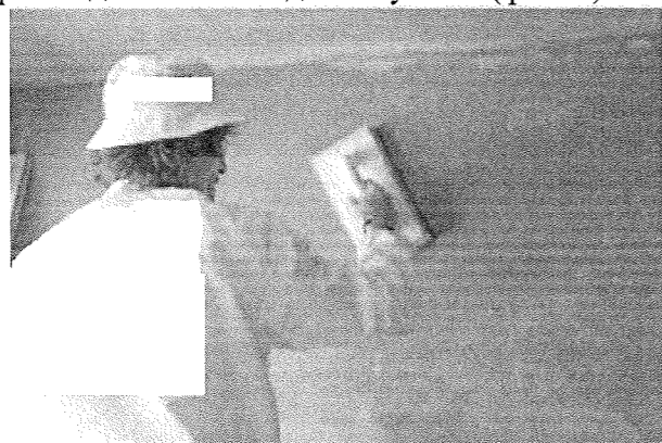
фиг. 4 Изпердашване на мазилка
