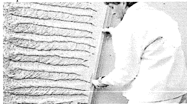
фиг. 2 Изтегляне на машинна мазилка
